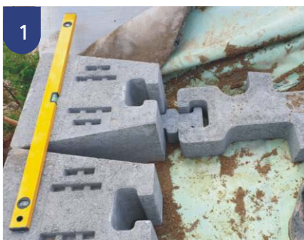
1 기초 첫단 설치
